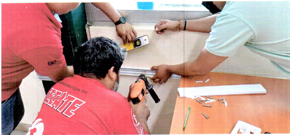
2.- Instalación de Canaletas
