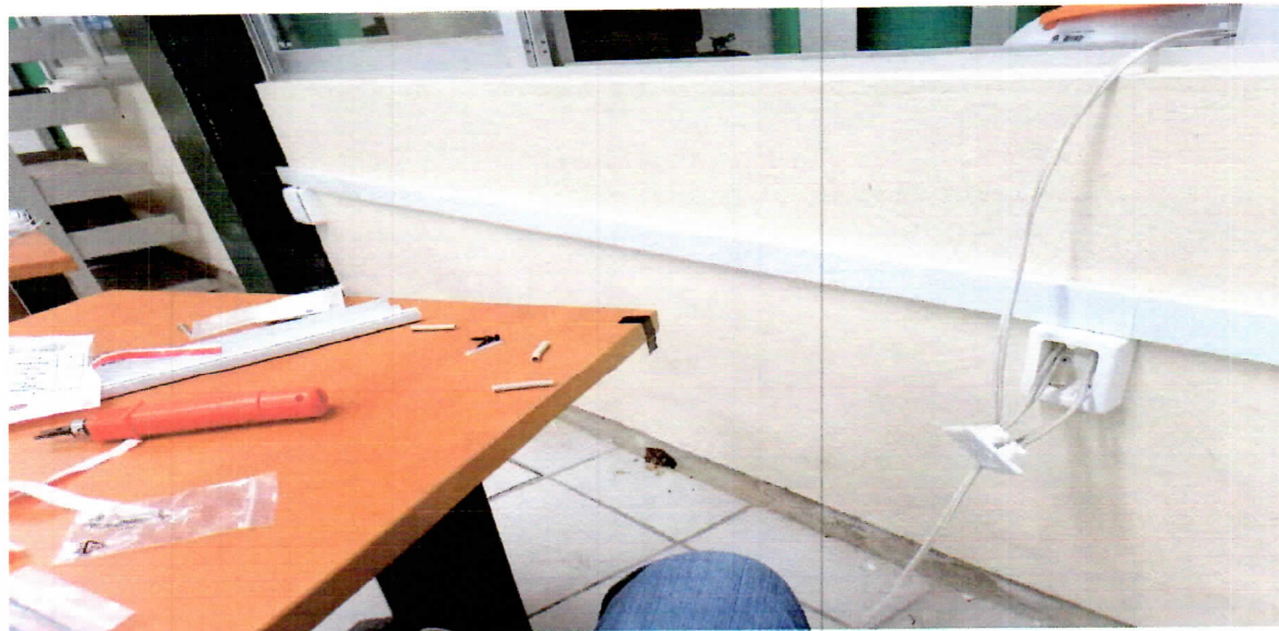
4- Colocación de cajas de red y Jacks
